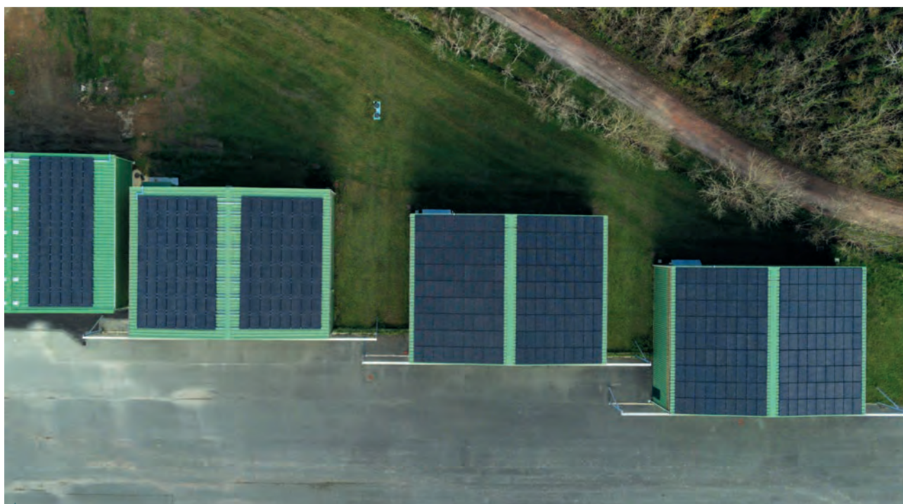
Panneaux photovoltaïque à l'aérodrome de Bois Fleury - Saint-Pierre-d'Oléron ©CCIO
